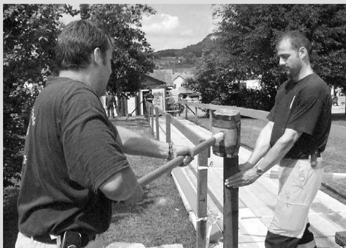
Daniel Gäumann (links) und Roger Beugger vom Sissacher Gemeindewerkhof bauen an der Passarelle zur Aula beim Tannenbrunnenschulhaus. Bild Rolf Wirz
